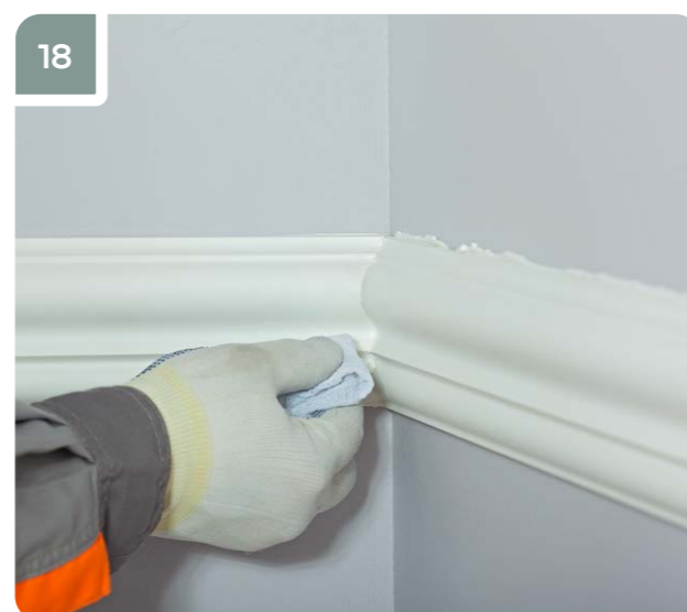
18 Протереть стык ветошью, смоченной ацетоном.
