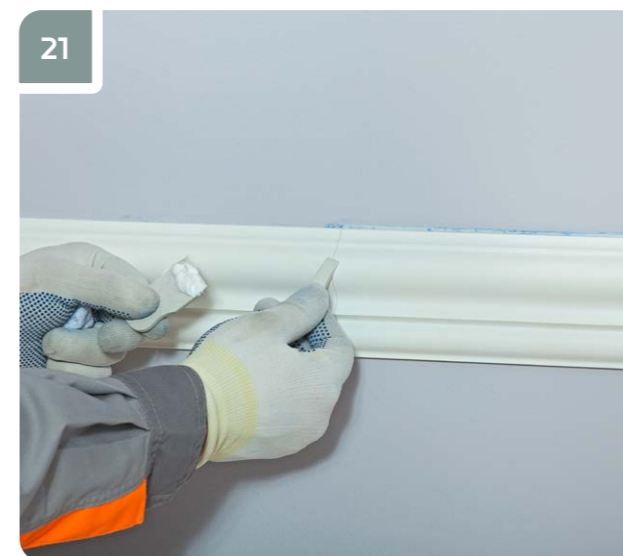
21 Финишной шпаклевкой для внутренних работ зашпаклевать обработанные стыки, при необходимости повторить «Шаг 20» до получения ровной поверхности.
